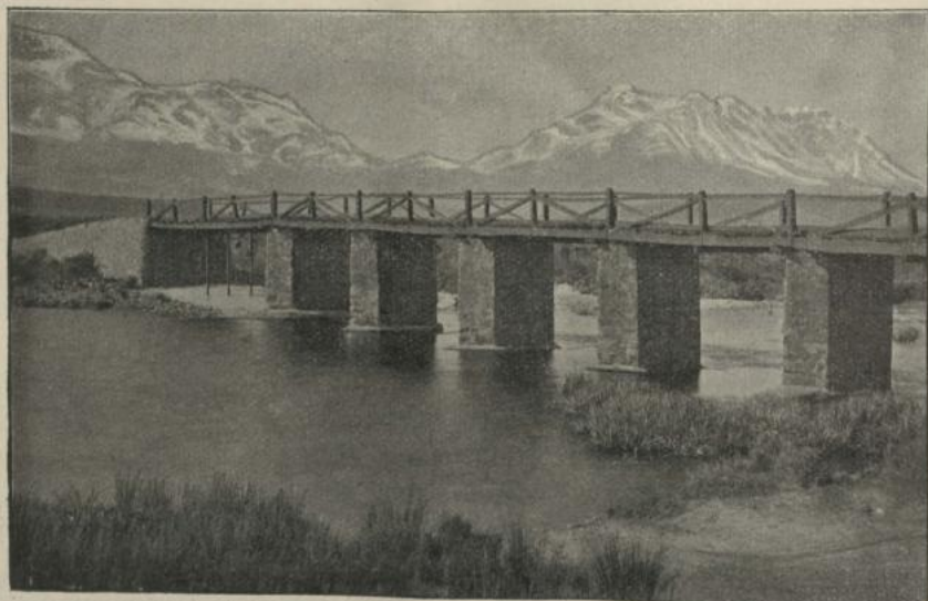
Die von der Mission erbaute Brücke über den Zonderendflus bei Gnadental.
