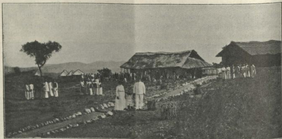
Wohnhaus (davor Geschw. Kruppa) und Barackenhaus (mit Raum für Baracke, Laden usw.) in Neu-Meya, Nyassa.
