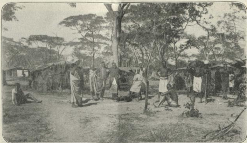
Ein Arbeiterlager an der Bahnstrecke Daresalam-Tabora.
