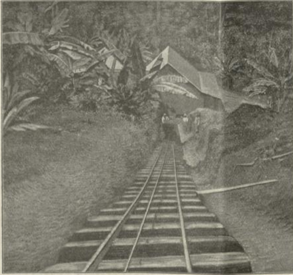
Drahtseilbahn im Goldminendistrikt zur Beförderung von Gütern über den größten Wasserfall im Waspuk.
