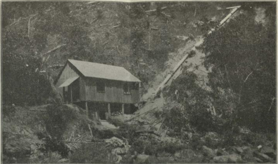
Das Elektrizitätswerk im Goldminendistrikt am Piz Piz in Nicaragua.
